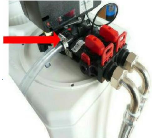
**Achtung:** Bei der Rückspülung wird für kurze Zeit hoher Druck über diesen Abwasserschlauch gefahren. Das andere Ende des Abwasserschlauches schließen Sie an einen geeigneten Abwasseranschluss oder einer Hebeanlage an, welche die Menge an Abwasser fördert.
